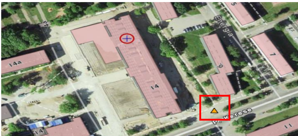
Pilt 8. Tuletõrje hüdrandi asukoht.
