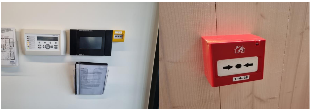
Pilt 5. Süsteemi keskseade + evakuatsioonivalgustuse juhtpult ja häireteatenupp
