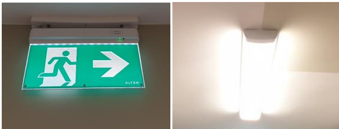
Pilt 9. Hoone turvavalgustussüsteem: evakuatsioonivalgustus (vasakul) ja näide paanikavältimisvalgustist hoone koridorides (paremal)
