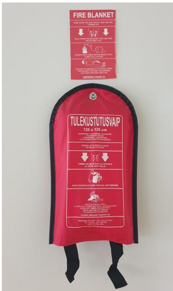
Pilt 11. Hoone tulekustutustekk (ühisköökides)
