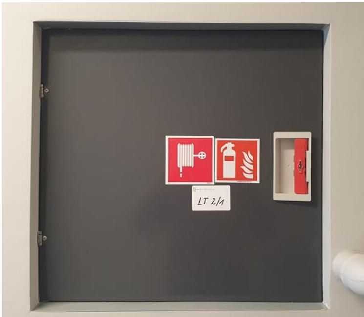
Pilt 7. Hoone tuletõrje voolikusüsteemi kapp
