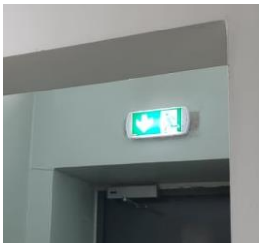
Pilt 9. Hoone turvavalgustusüsteem: evakuaatsioonivalgustus (vasakul) ja näide paanikavältimisvalgustist hoone 4.püstakus (paremal)
