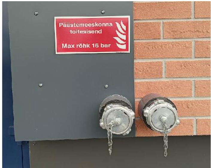
Foto. Korrustel olevad märgtõusutoruapid ja välised toitesisendid.
